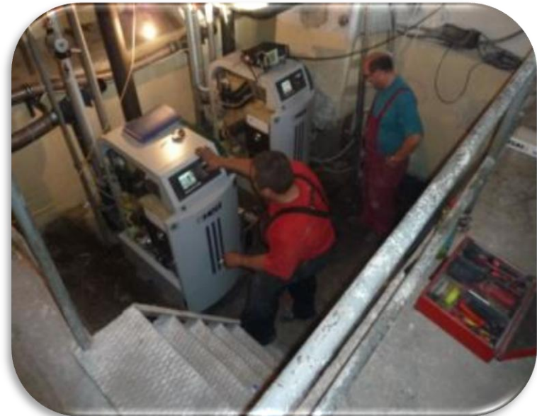
Objekt Obecného úradu Papradno: 2 nové kotly s výkonom 30 kW
